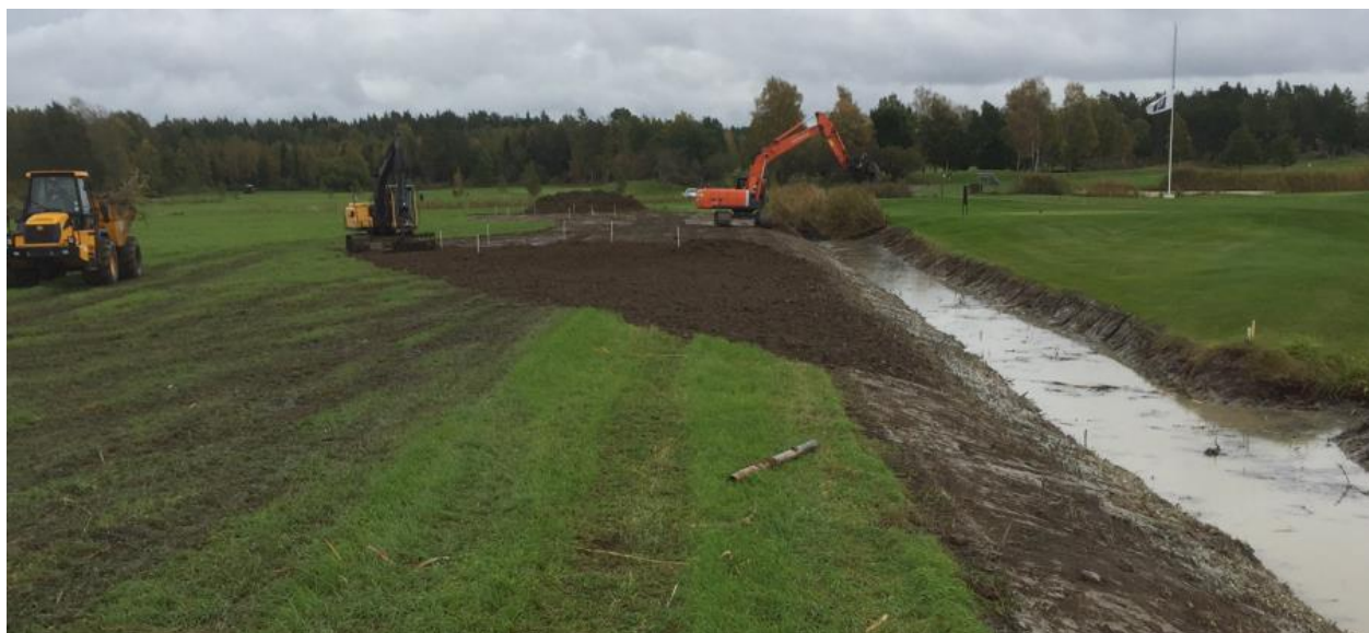
Bilden visar arbetet med nya utslagsområdet och nya sträckningen på håll 1
